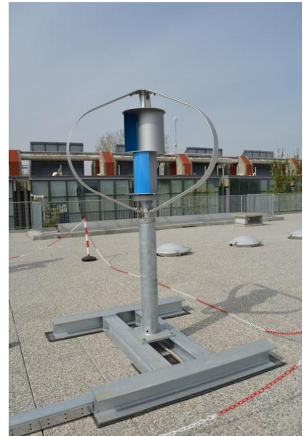
El poste del aerogenerador de eje vertical debe respetar el diseño de la brida de conexión del propio generador, es posible realizar postes autoportantes con estructuras de hierro para evitar perforar el techo.
